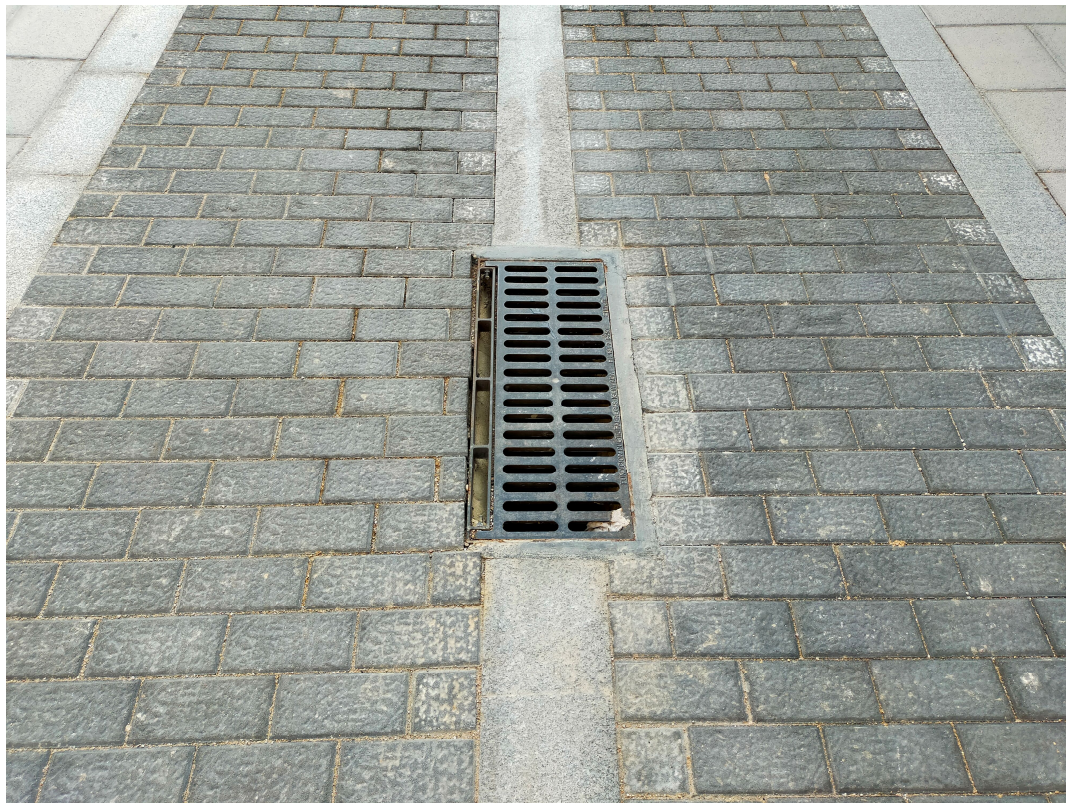
Figura nº 4. Localización de imbornales en la rigola central de la calle.
